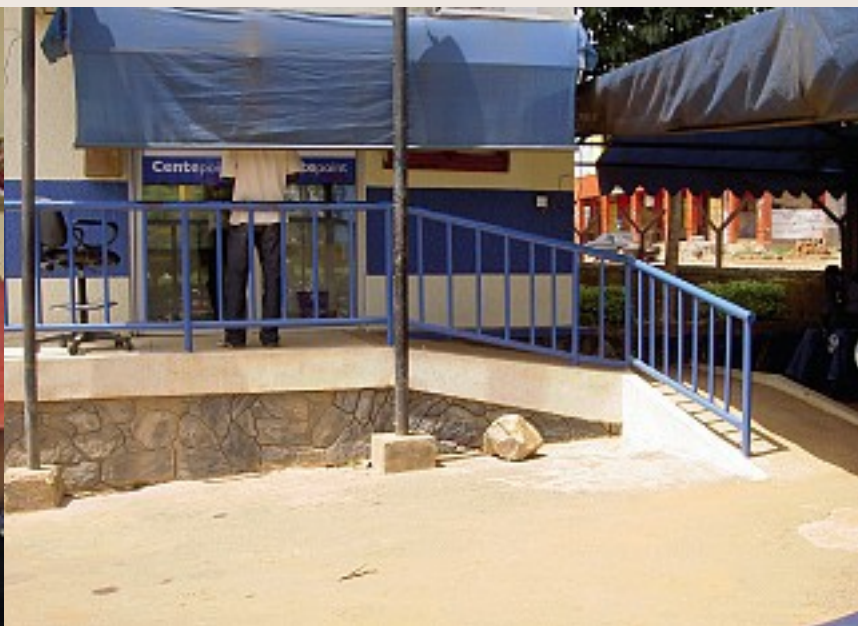
Den nybyggede rampe til banken.
